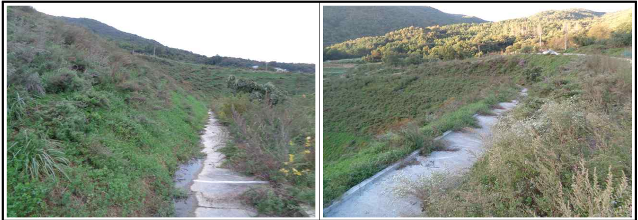
【그림 16.3.3】 배수시설 전경
